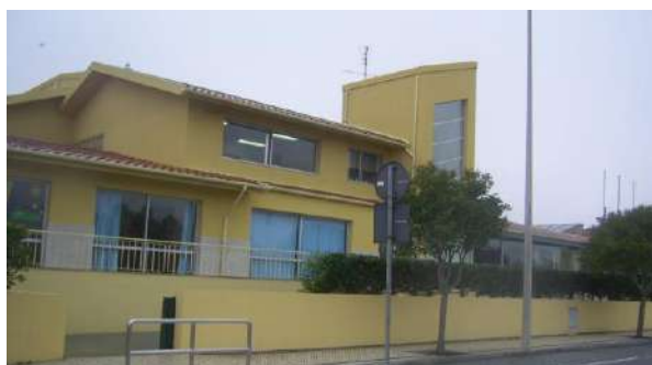
Edifício Monsenhor Pires Quesado
